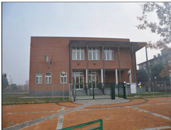
Fotografia 14 Scuola secondaria di primo grado
