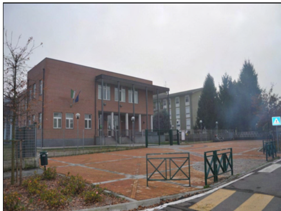
Fotografia 15 Scuola secondaria di primo grado
