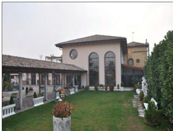
Fotografia 106 Albergo ristorante La Fornasetta
