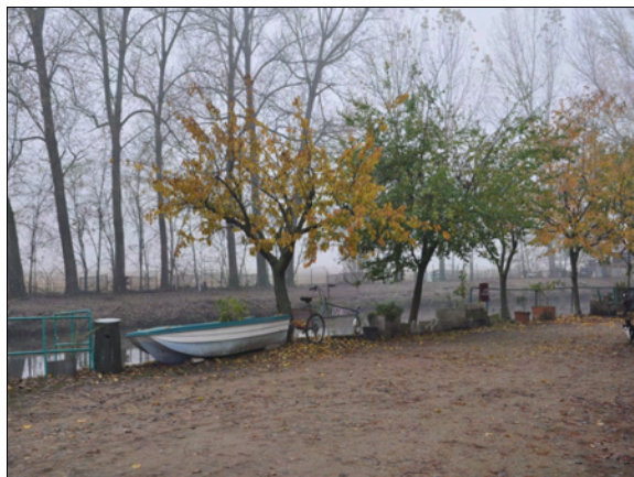
Fotografia 92 Impianto di depurazione
