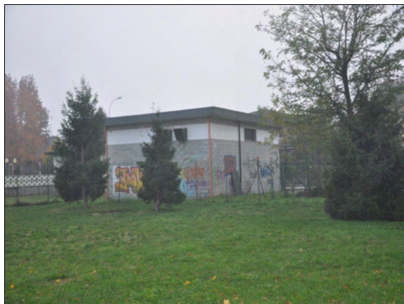
Fotografia 91 Cabina elettrica, del telefono e del gas
