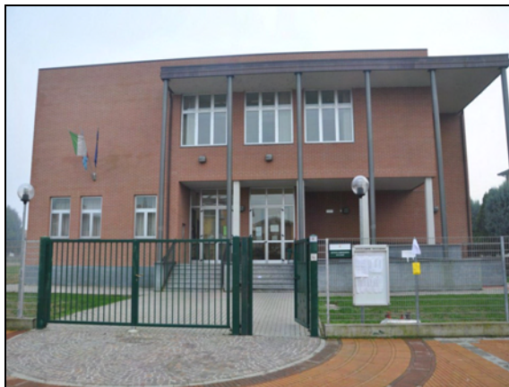
Fotografia 16 Scuola secondaria di primo grado
