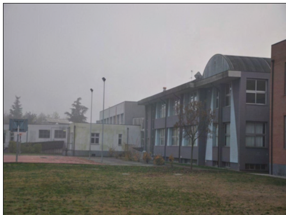
Fotografia 13 Scuola secondaria di primo grado
