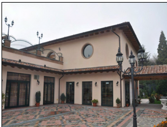
Fotografia 109 Albergo ristorante La Fornasetta
